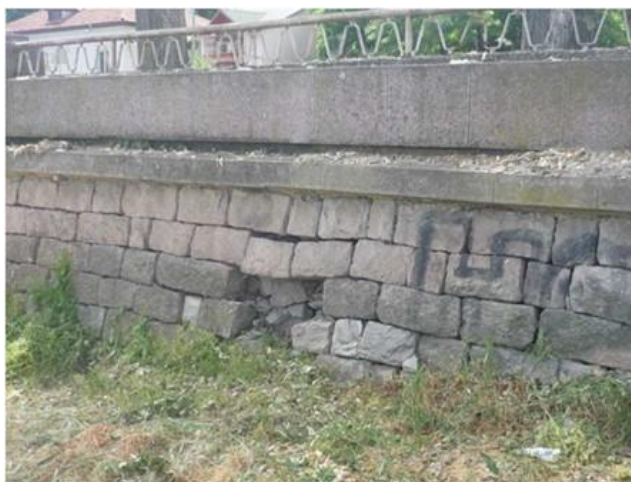
Фигура 20: Разрушения по подпорната стена
